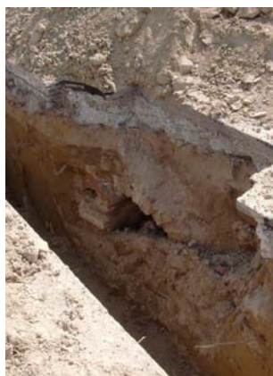
A Széchenyi tér keleti oldala mentén 1905-ben építették (a sarki Plihál-háztól a Fő útig) e csatornát
