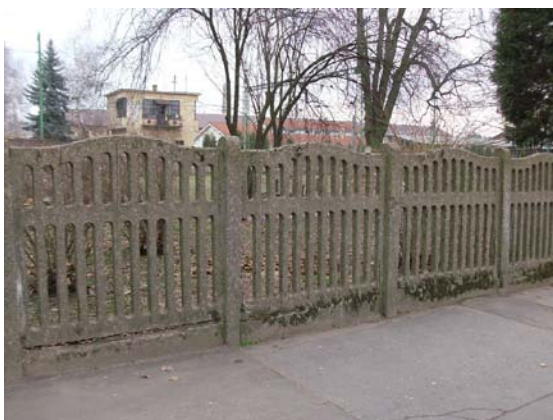
Betonból öntött kerítés az épület déli oldalán
