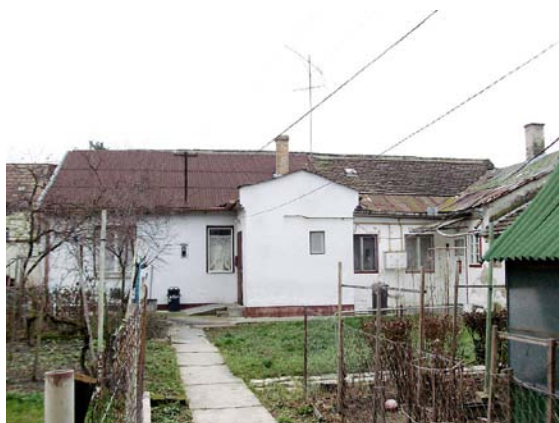
A hajdani iskola épülete
