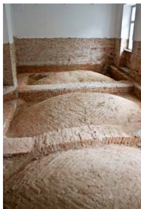
A pince boltozata egy földszinti teremben a 2010-es felújításkor
