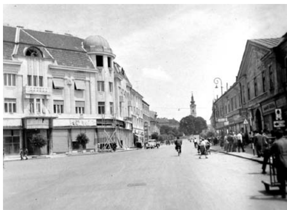
Folyik az épület 1963-as átalakítása
