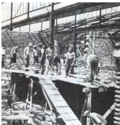
Az építési munkák
