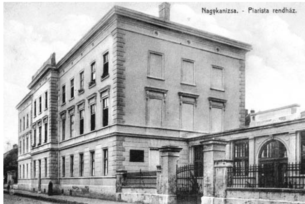
Az utcai épület az átépítés után
